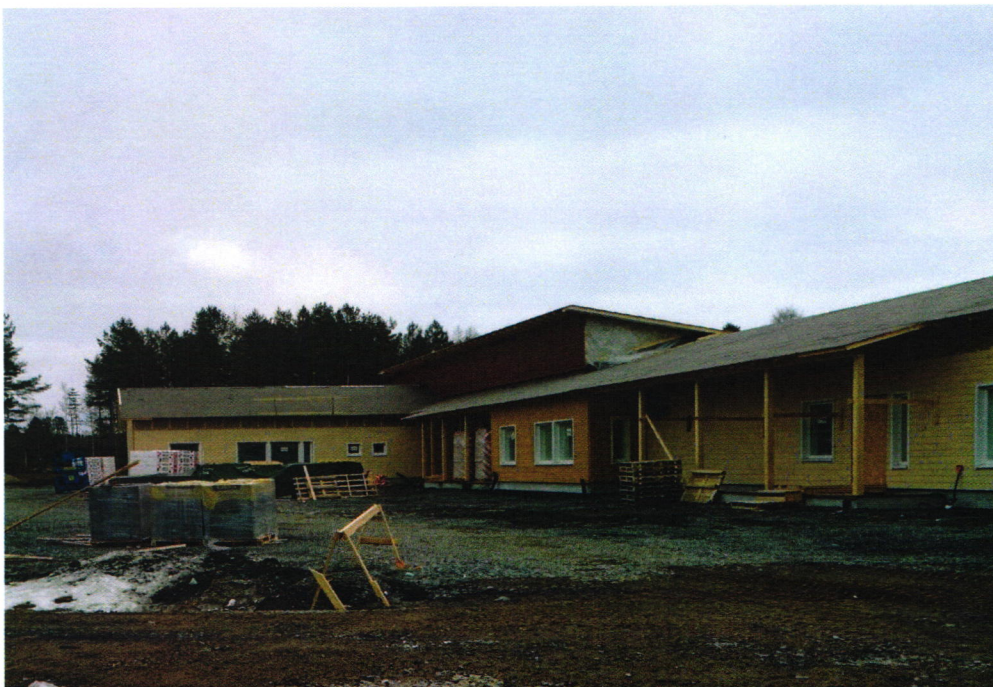
Kuva: valmistumassa oleva päiväkoti
