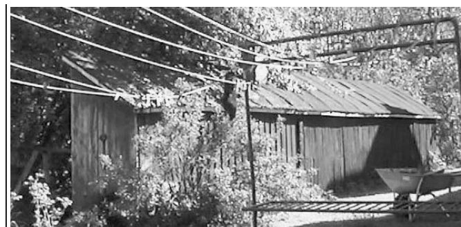
Aukusti Perkkiön mökin sauna ja liiteri (Kuva: Janne Laukka, Vanhojen rakennusten säilyttämisprojekti Ylivieskan seutukunnassa, 16.06.01)
